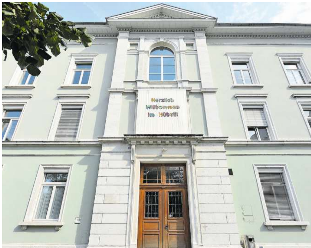
Das frei werdende Primarschulhaus Hübeli in Olten kann vorübergehend vom heilpädagogischen Schulzentrum genutzt werden. Bild: Bruno Kissling
